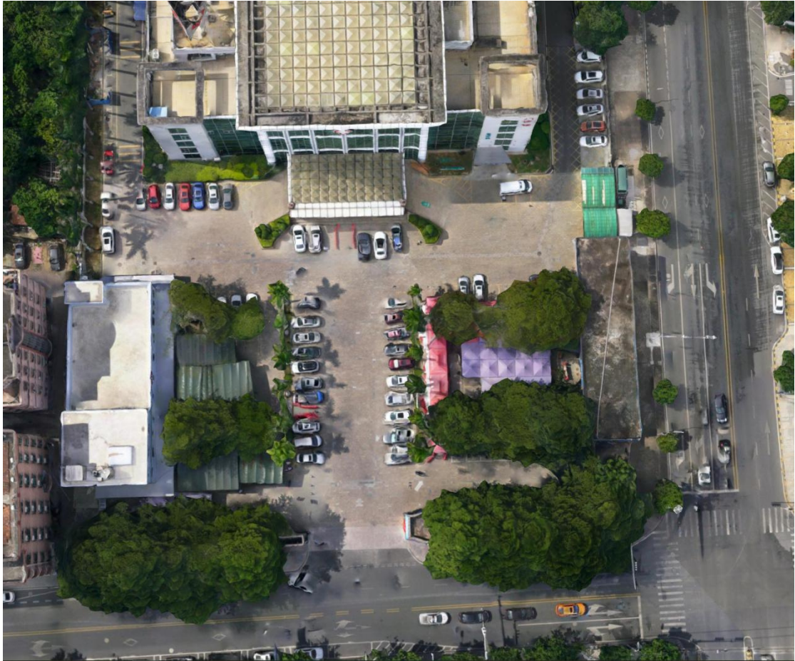
图 10-5 东坑医院配建停车场情况
