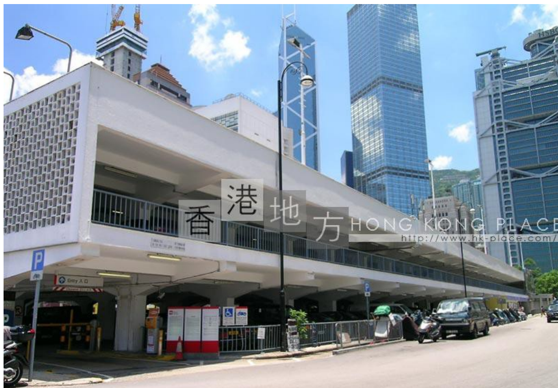
天星码头多层停车楼
