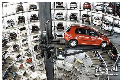
高度集约化的立体停车楼
