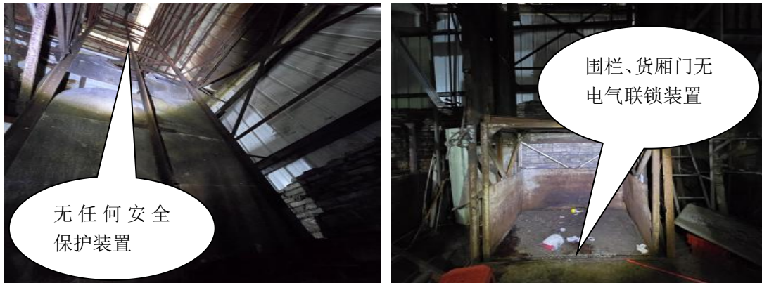
图 12 未安装停层保护装置 图 13 围栏、货厢门无电气联锁装置
