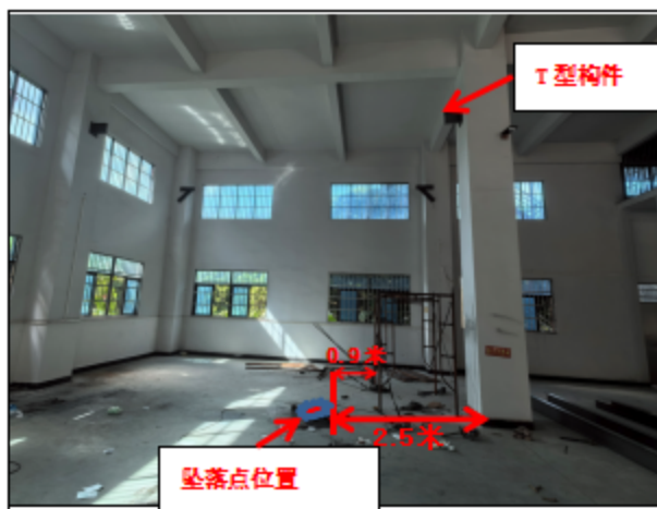
图3 事故现场坠落点、脚手架、T型 构件位置图
