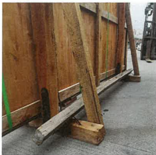
图4 支架一侧的加强方木条已松脱
