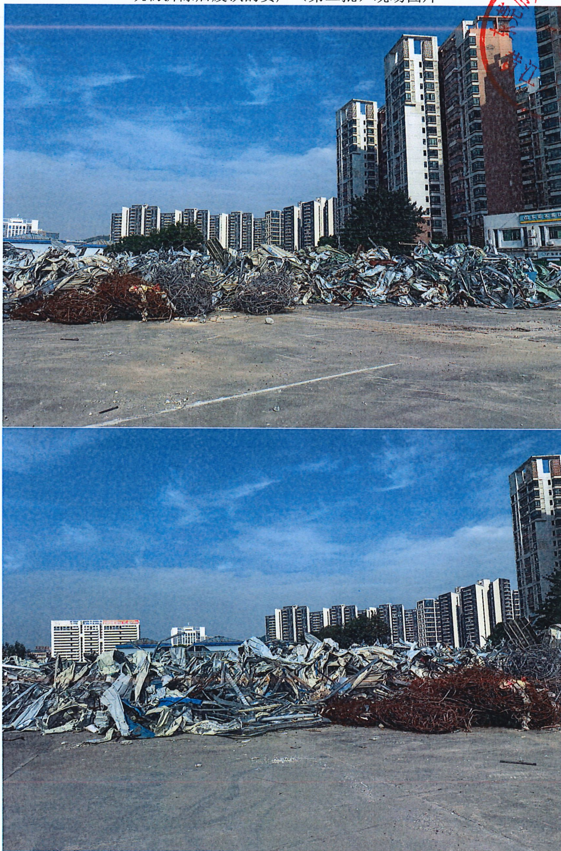
市轨道交通 1 号线黄江段相邻地块和红线外信宜村及安置地块上房屋等建（构） 筑物拆除后废铁的资产（第二批）现场图片
